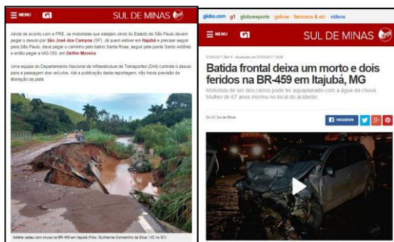
Figura 2 – Ocorrências na BR 459 Fonte: MINAS (2017).
