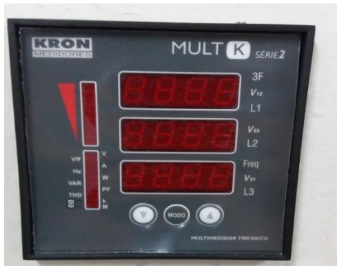
Figura 8: Módulo de medição – Multimetro Multk série 2 ( KRON) - Fonte: O autor
