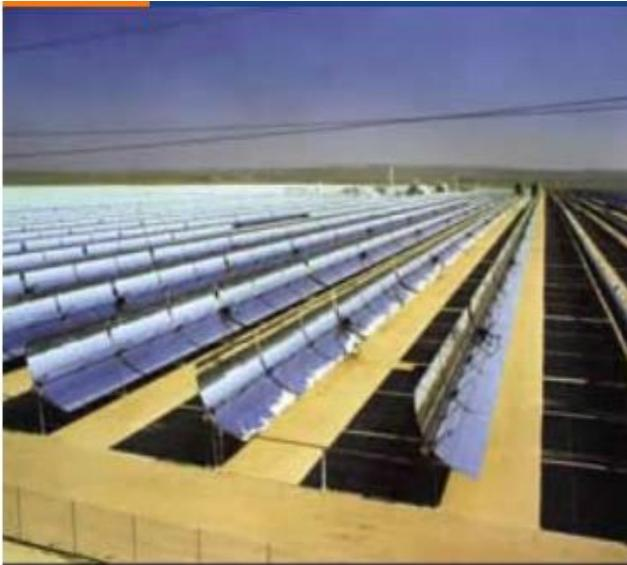
Figura 2 - Sistema térmico de geração solar de energia elétrica (Califórnia – USA) [3]
